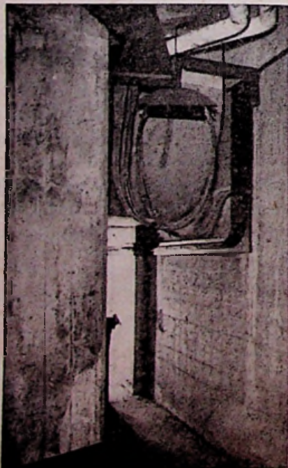
Links: De kabelverbindingen lopen via verende tableaux in wijde lussen van de binnen- naar de buiten-„doos".
